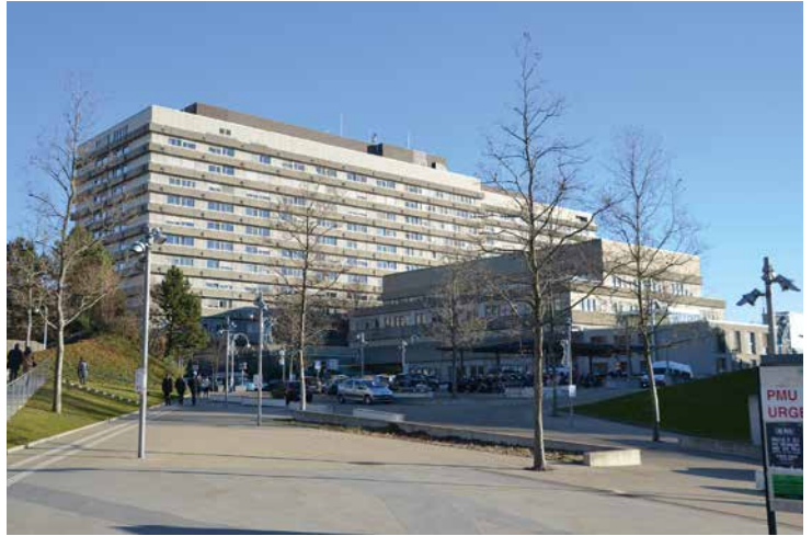
Le complexe du CHUV, à Lausanne.
