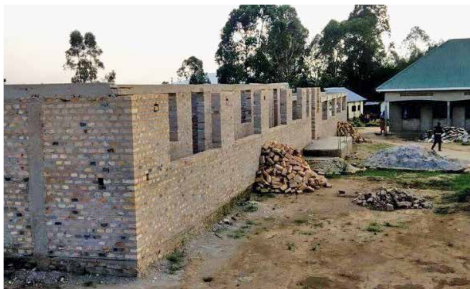
Le dortoir en construction.
