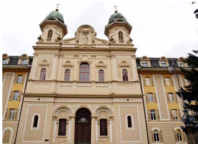
Schwyz: l'ancien collège néobaroque des Jésuites (1841), siège actuel du gymnase cantonal.
