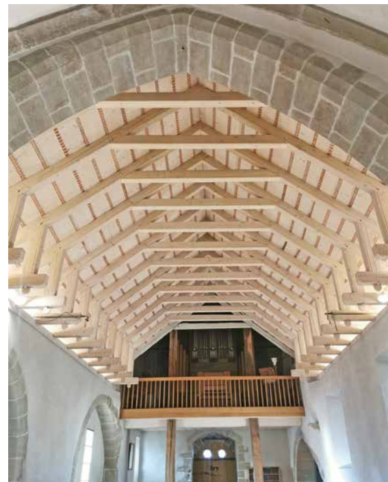
La charpente telle que restaurée en 1974.
