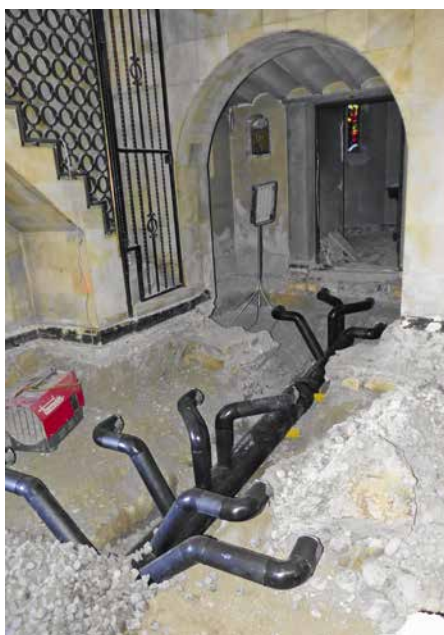
Pose de la ventilation dans l'église et sa machinerie par le toit de la sacristie.
