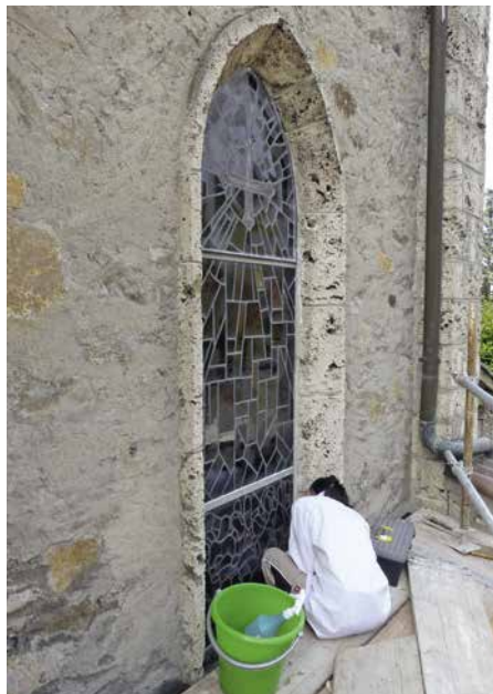
Nettoyage et réfection des vitraux.
