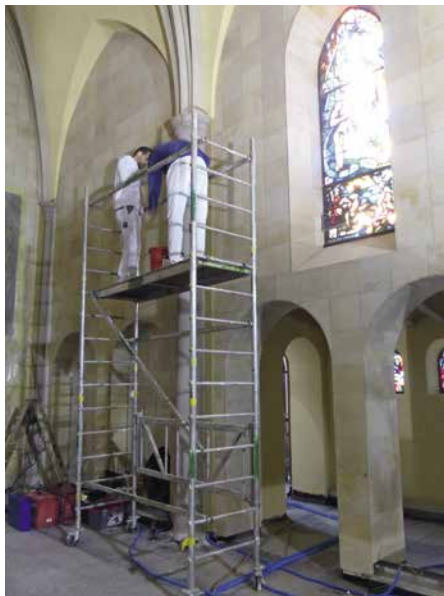
Application des peintures du chœur, de la nef et des colonnes.
