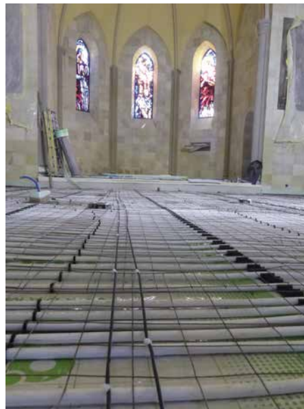
Installation du chauffage au sol et de la boucle magnétique.
