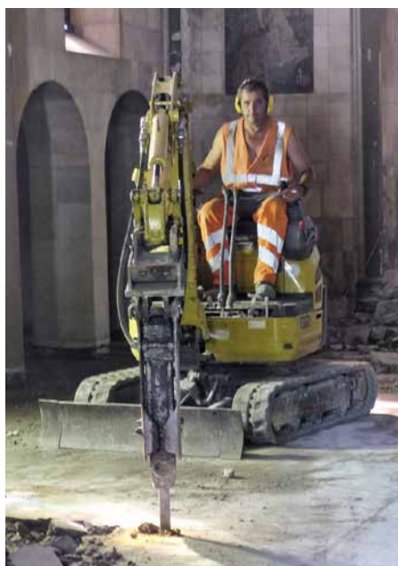
Creuse de 60 cm pour abaisser et retrouver le sol d'origine.
