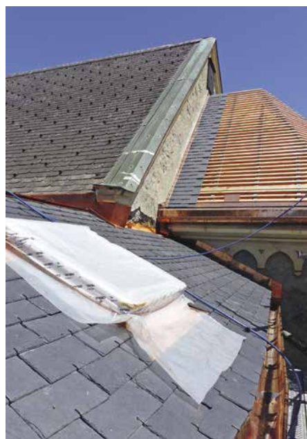
Démolition et reconstruction du toit du chœur avec des tuiles en ardoise.
