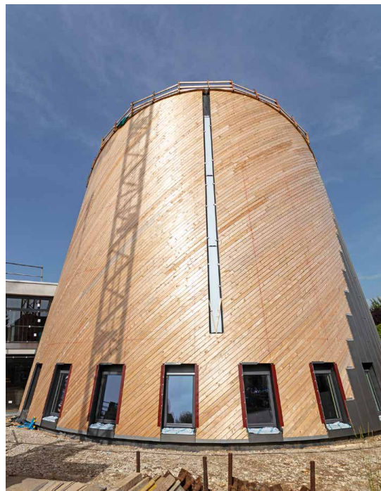
La messe en plein air a eu lieu devant l'église de Gland en construction.
