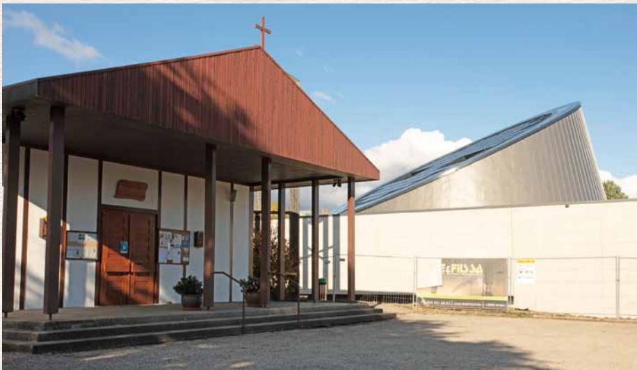
Après d'intenses réflexions, la nouvelle église sera finalement construite à côté de l'ancienne chapelle, pour que cette dernière puisse être utilisée pendant les travaux.
