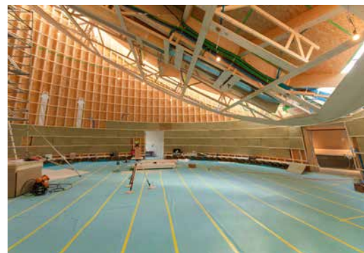
L'intérieur de l'église en construction.
