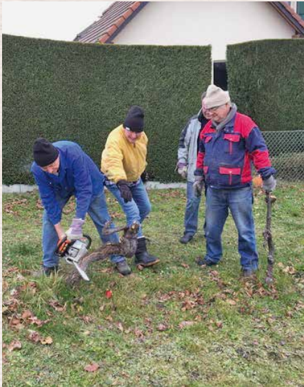
L'arrachage de la dernière souche des vignes, pour libérer le terrain à la construction.
