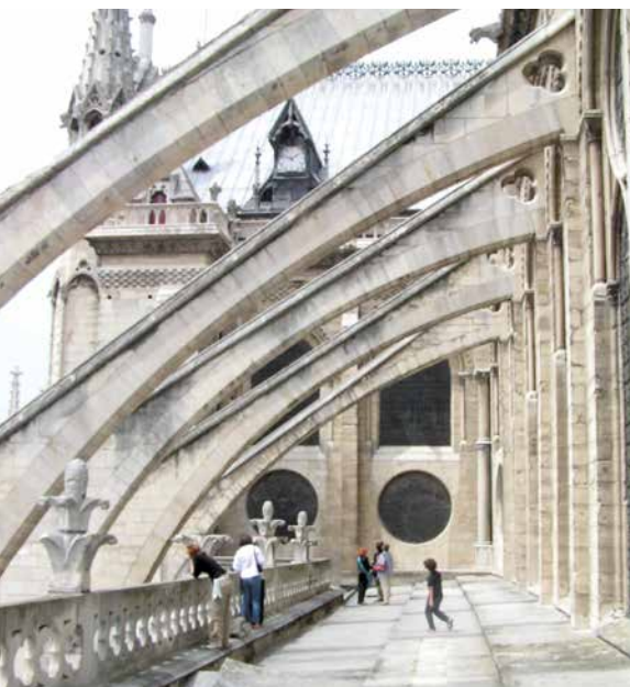
L'invention des arcs-boutants a permis de soutenir des murs hauts et fins.
