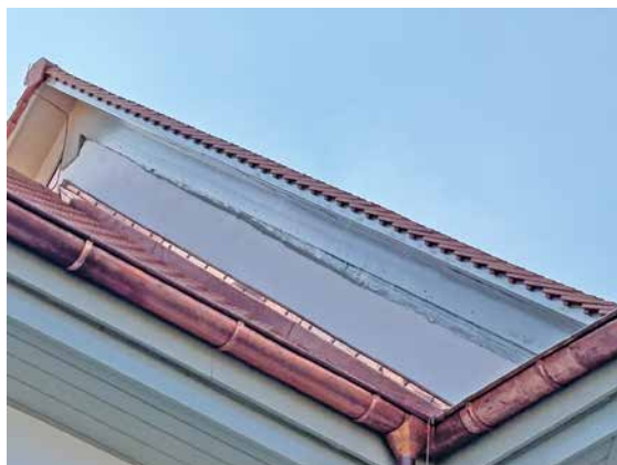
Les larmiers, gravement endommagés, ont dû être remplacés.
