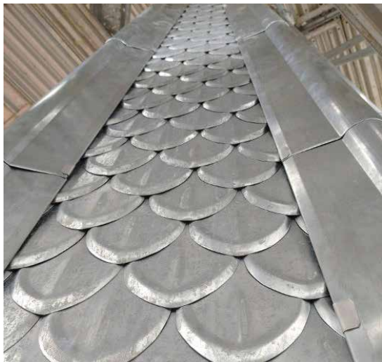
Sur le clocher, la couverture en éternit a été remplacée par des écailles de zinc.
