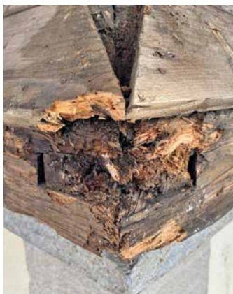
Les larmiers, gravement endommagés, ont dû être remplacés.
